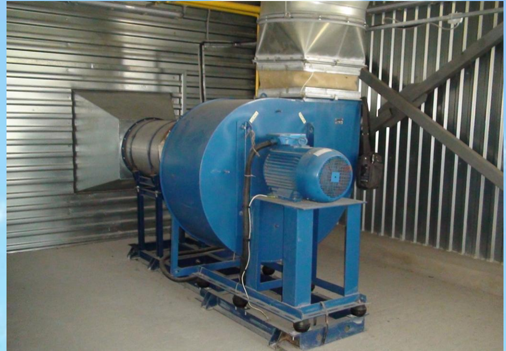
Расположение установки в помещении венткамеры
